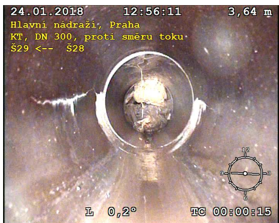
FOTO Š29-Š28.1 (úsek 19) Praskliny vlevo + vpravo a dolní části
