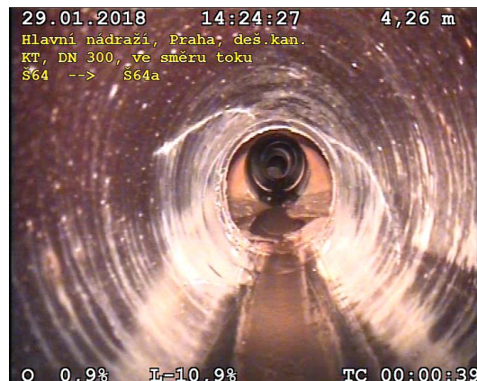
FOTO Š64-Š64a (úsek 50) Praskliny vlevo + vpravo
