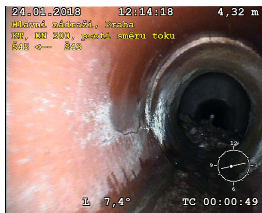
FOTO Š43-Š42.2 (úsek 16) Prasklina podélná vlevo u spoje
